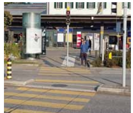
4 | Kein gutes Beispiel: Diese Insel ist für einen Rollstuhlfahrer zum Anhalten zu klein. 4 | Mauvais exemple: cet îlot est trop petit pour qu'une personne en fauteuil roulant puisse s'y arrêter..
