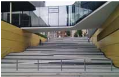
3 | Kein gutes Beispiel: Für einen Rollstuhlfahrer viel zu streng, um auf dieser «Zickzack-Rampe» hochzufahren. 3 | Mauvais exemple: pour une personne en fauteuil roulant, beaucoup d'efforts pour monter sur cette rampe «en zigzag».
